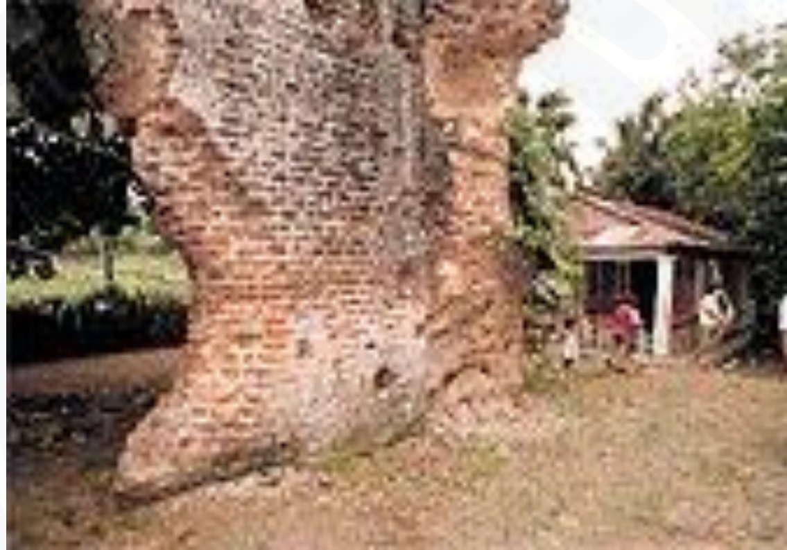
Fig. 2. Ruinas de una columna de la Catedral de Vega la Vieja destruida por el terremoto de 1562.
